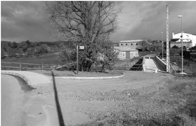
Vorera nova a la passarel·la de Santa Creu de Jutglar. Gener 2013.
