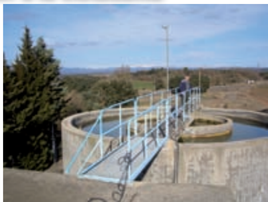
Feines de manteniment a la depuradora
