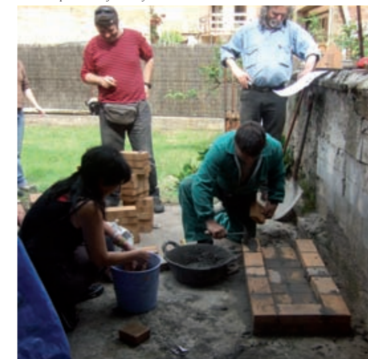
Posant les primeres rajoles del forn de ceràmica
