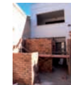
Obres ascensor d'accés al Centre Activa't
